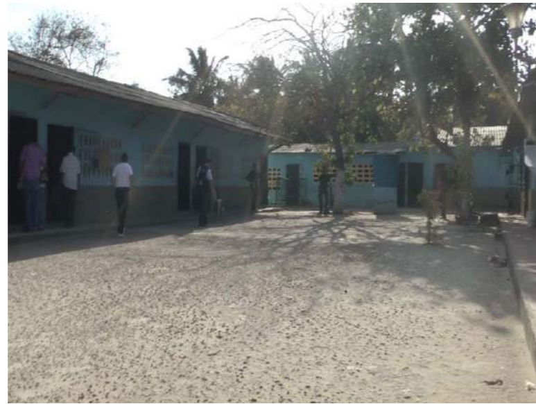
Vista del colegio público del corregimiento de Palermo que se acondicionó como puesto de votación
